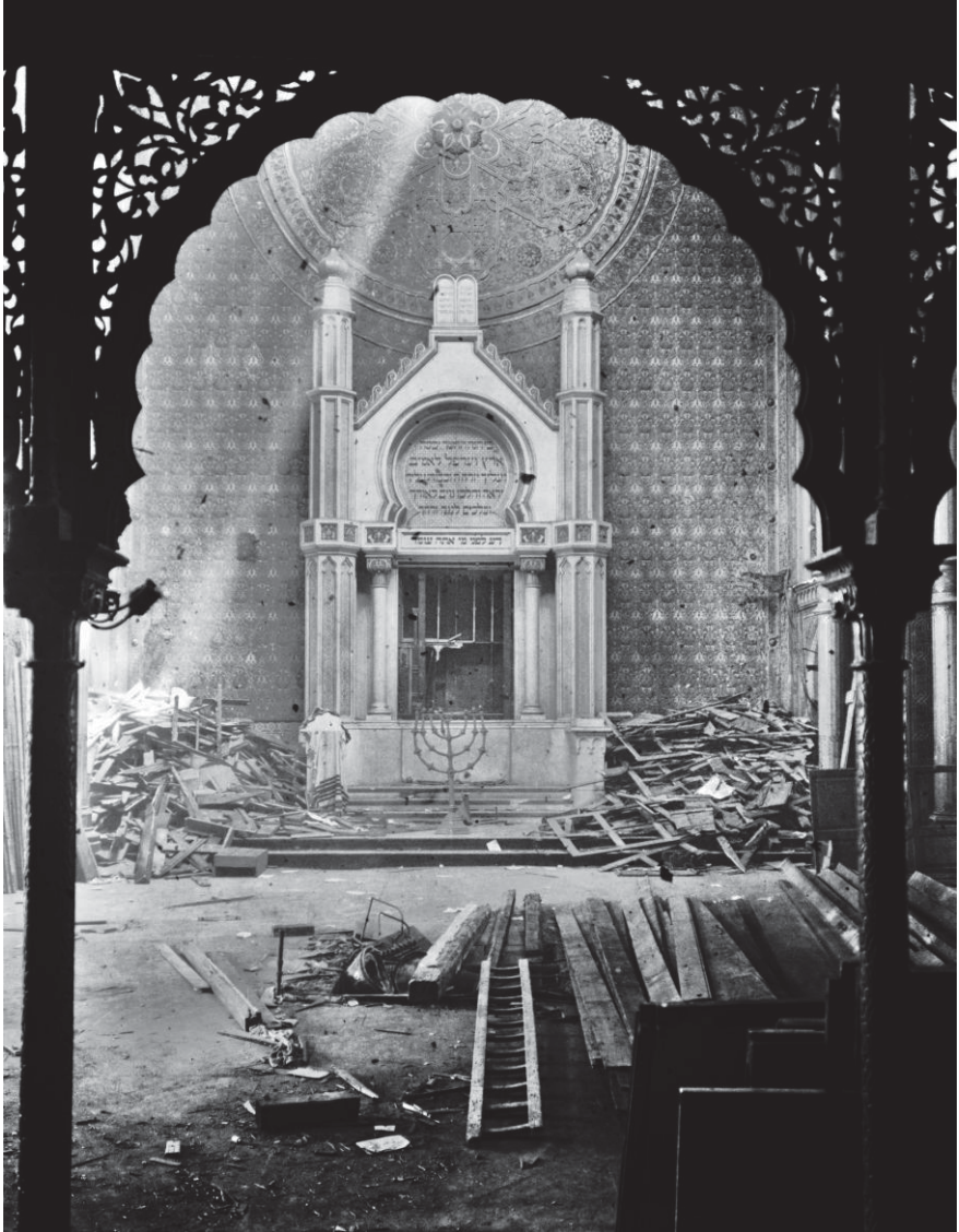
Abb. 21 Nach dem Pogrom von November 1938. Rechts die noch brauchbaren Hölzer, die vermutlich von den Emporen stammen, Zustand 1939.
