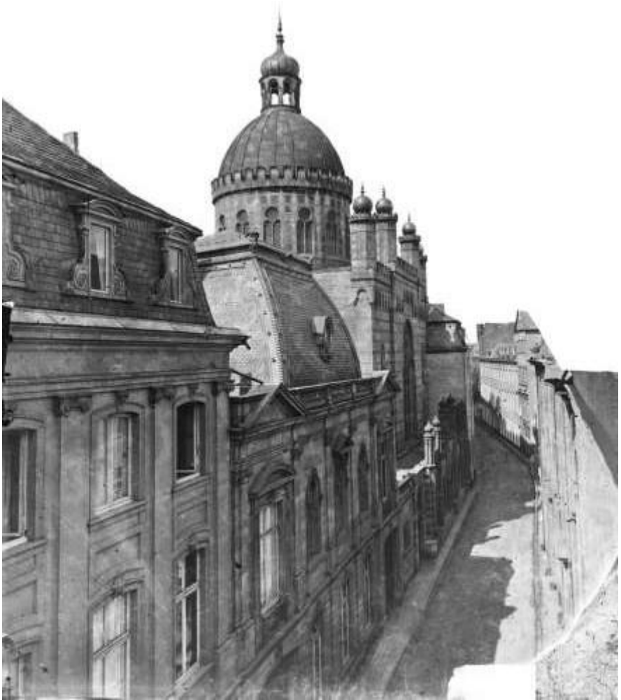
Abb. 18 Die Glockengasse mit der Synagoge und dem sich östlich anschließenden Palais Oppenheim, Blick nach Westen, 1870.
