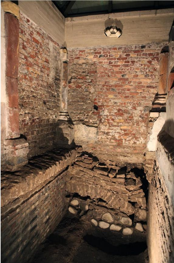
*Abb. 11: Vorraum der Mikwe, Blick Richtung Osten. Im Hintergrund die Ostwand (mit Fundament) mit zugemauertem ehemaligem Zugang. An den Ecken die zwei Pfeiler mit Eckspornbasen. Rechts die Nordwand des 15 m tiefen Schachts. Die Oberkante des Fundamentvorsprungs an der Nordwand des Vorraums (links) markiert in etwa die Höhe des ursprünglichen Fußbodens. Unter diesen Absatz wurde die Mauer aus Sicherheitsgründen modern unterfangen.*
